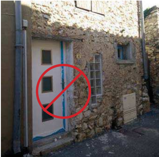
EVITER DE REMPLACER LA PORTE PAR UNE PORTE STANDARD ET DE METTRE DES PAVÉS DE VERRE EN FAÇADE.
