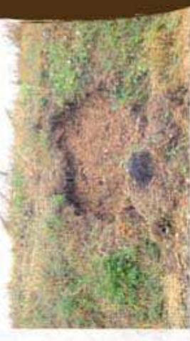
Erosion du talus due au manque de végétation pour retenir la terre.
