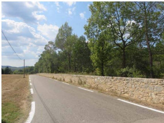
Le mur le long de la RD 30, lieudit Notre Dame
