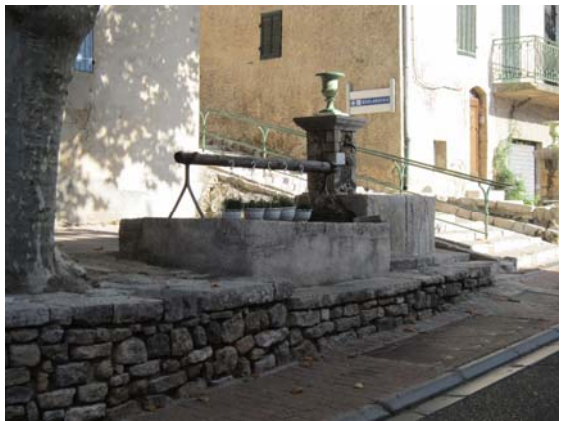
Fontaine au village, Abords de la RD 554
