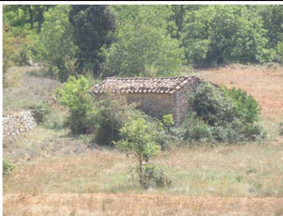
Cabanon sur l'ancien ch de Varages, parcelle 254
