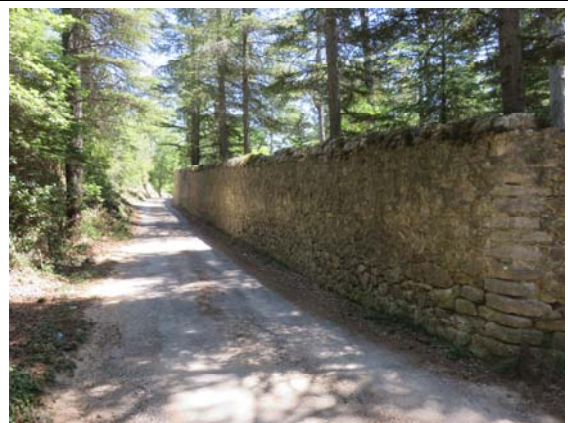
Mur du parc du château (parcelle 120)
