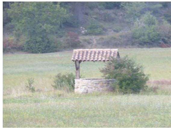
Puits au lieudit Beinets, parcelle 336
