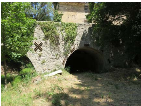
Pont sur la RD30, au-dessus du vallat du Pont
