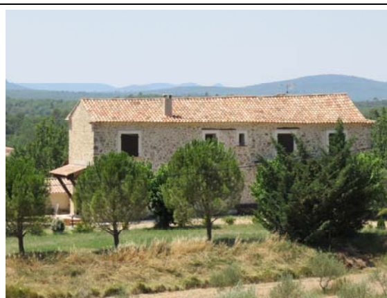
Ancienne ferme Lieudit Bellevue, parcelle 815
