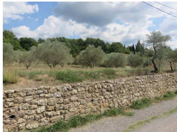
Restanques sur l'ancien chemin de Varages
