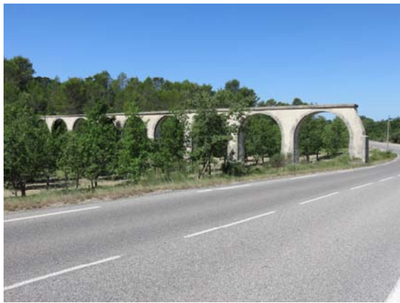
Aqueduc de Naï Lieu dit Bramefan, parcelle 661
