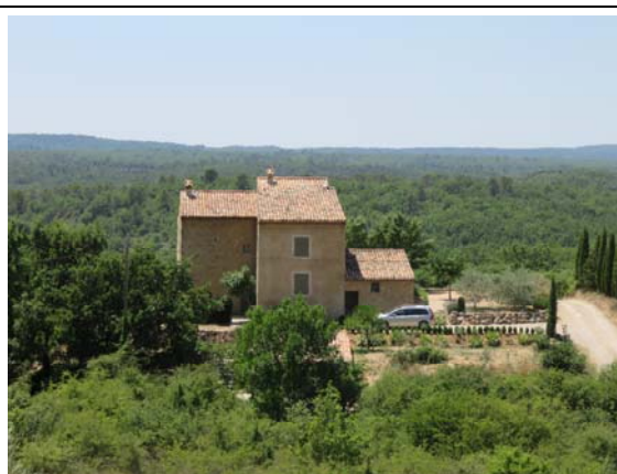
Ancienne ferme Lieudit Bellevue, parcelle 161
