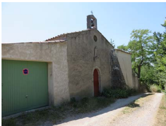
Chapelle Notre Dame d'Eglise Lieudit ND d'Eglise, parcelle 179
