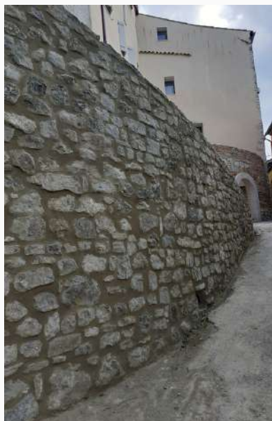
TRAVAUX MUR EN PIERRE RUE PARADIS
