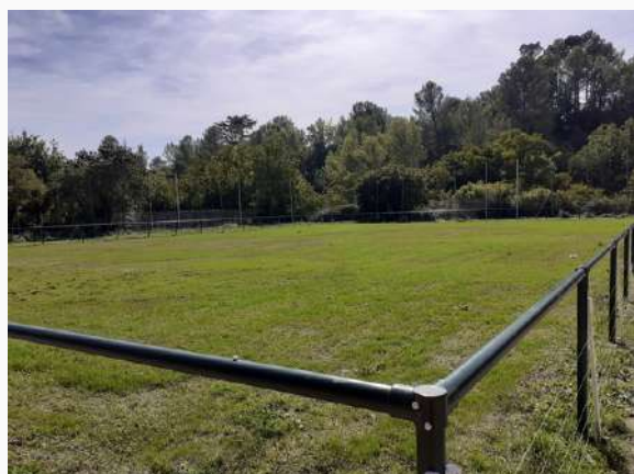
Installation d'un nouveau terrain de football
