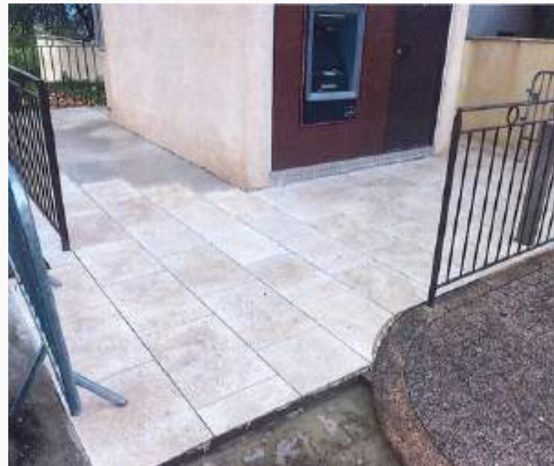
POSE DE CARRELAGE AUTOUR DU DISTRIBUTEUR
