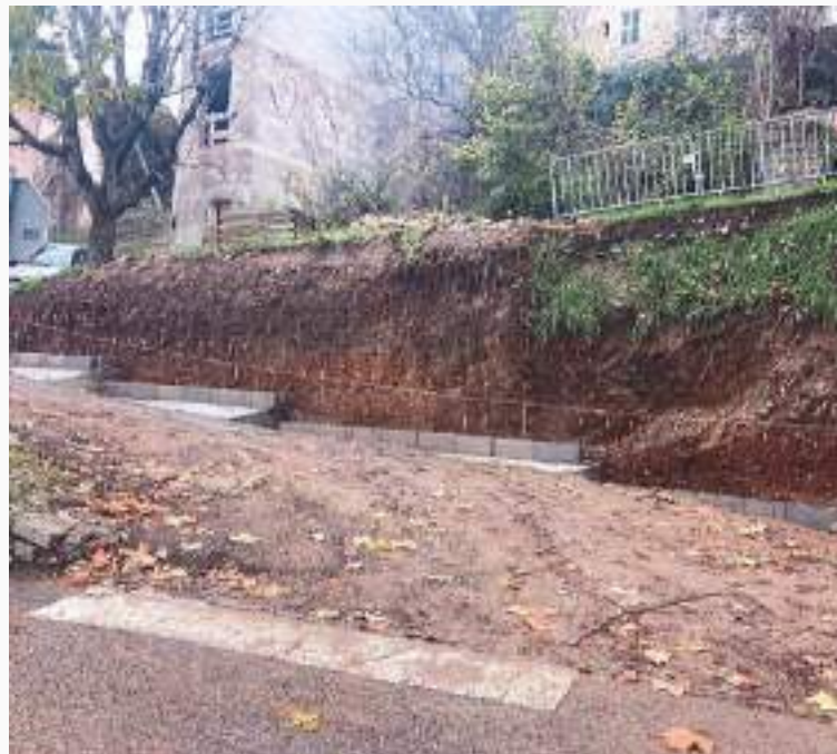
LANCEMENT DES TRAVAUX RUE DU NORD
