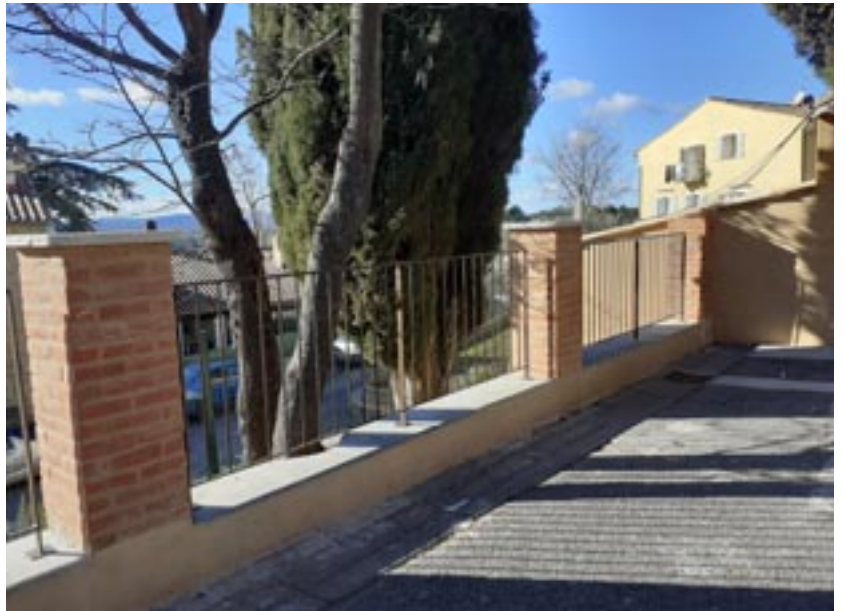
TRAVAUX AVANT - APRES ECOLE
