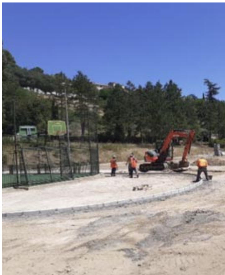
TRAVAUX BASE DE LOISIRS, CONSTRUCTION STADE DE FOOT À 5, D'UNE PISTE CYCLABLE ET D'UN PIÉTONNIER AUTOUR DU CITY STADE MAI 2025
