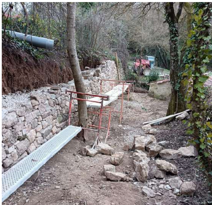
Travaux lavoir de Fontvieille réhabilitation des murs en pierre
