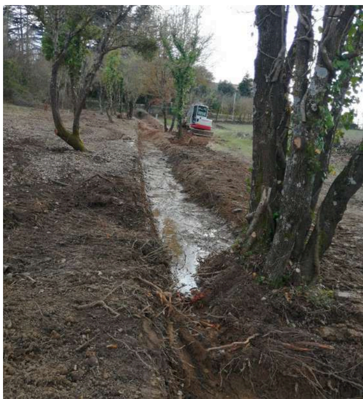
Travaux lavoir de la Gorgue
