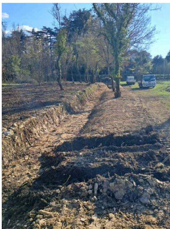
Travaux lavoir de la Gorgue
