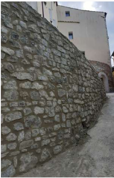
TRAVAUX MUR EN PIERRE RUE PARADIS
