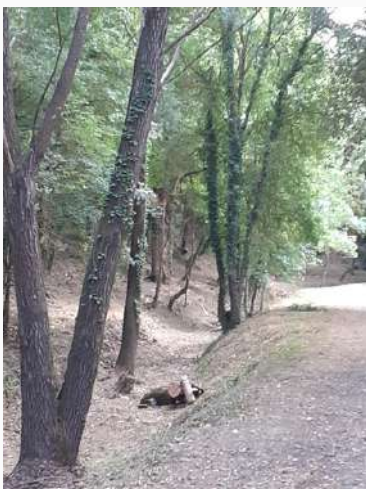
TRAVAUX FORESTIERS AUTOUR DU RUISSEAU MENANT AU LAVOIR
