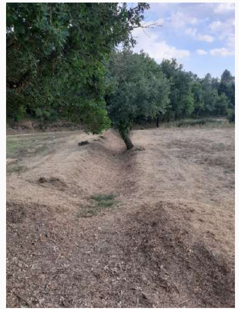
TRAVAUX FORESTIER ET CURAGE DU FOSSE QUARTIER CHICHERI
