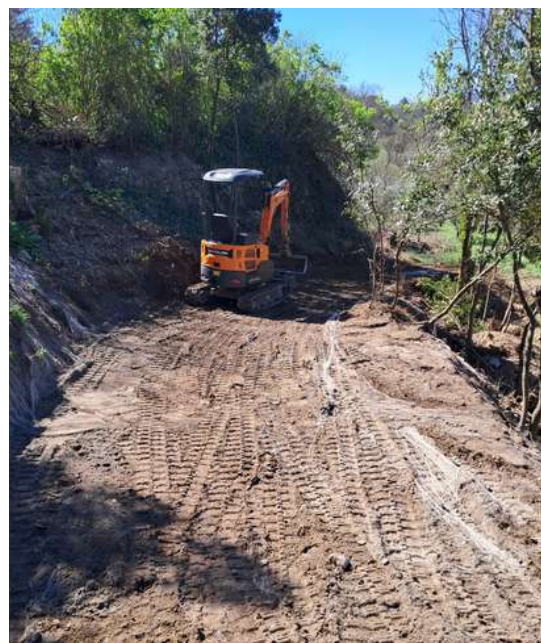
TRAVAUX CHEMIN DES FERRAGES
